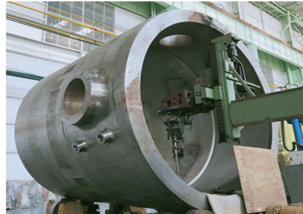
RPV支撑段筒体堆焊
