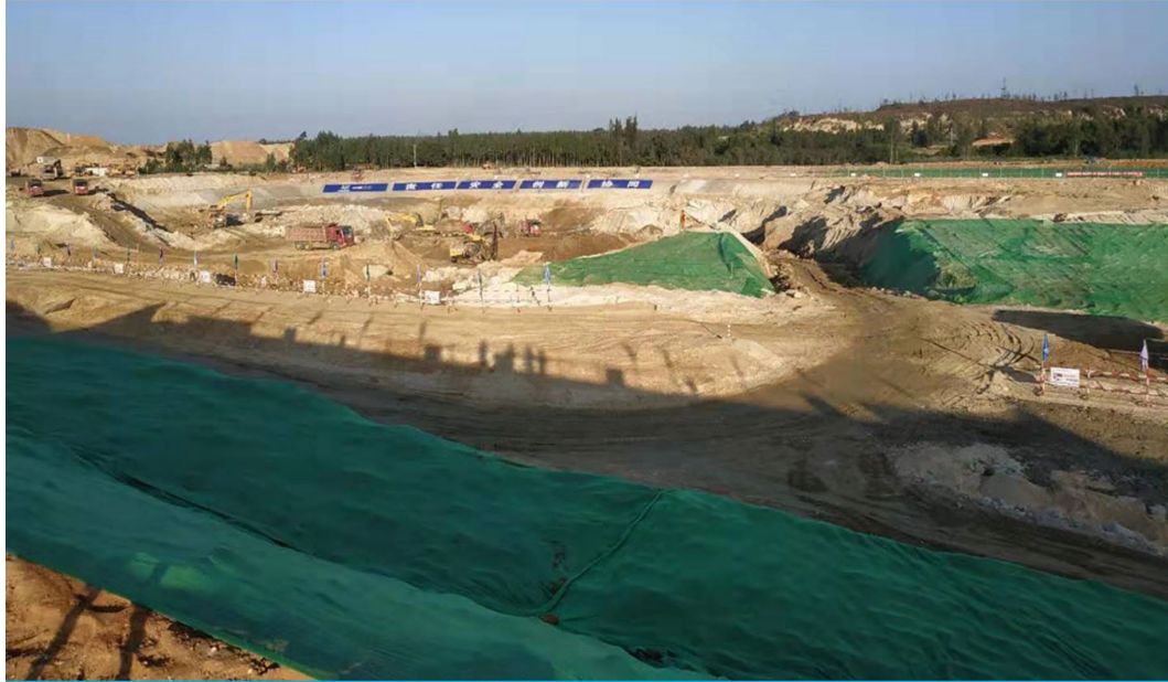
小堆施工现场
