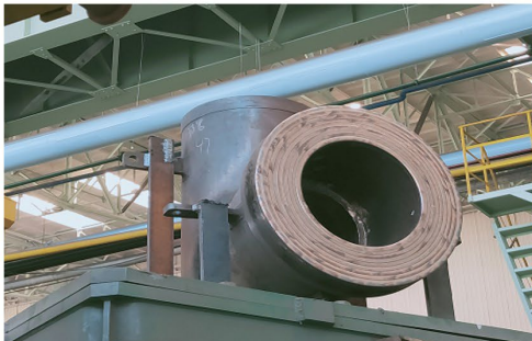
RPV主泵接管待堆焊
